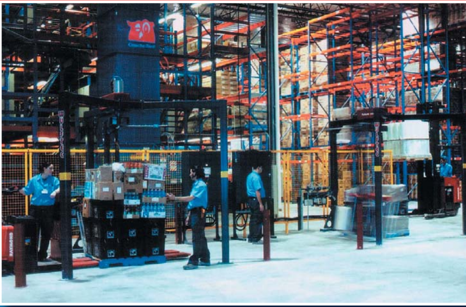
Conçu et réalisé par Technirack, le module de cueillette est étalé sur trois niveaux, et possède une surface totale d'utilisation de 25 000 pi 2 . Au sein de cette structure, la pige y est facilitée grâce à un système de convoyeurs serpentinant à l'intérieur du module.
